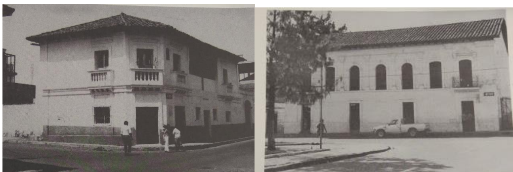
Figura 10. Vivienda de dos plantas ubicada en la Calle Carlos Freire y coronado 1940. Fuente: Quito Comunas y Parroquias - Municipio de Quito 1992
