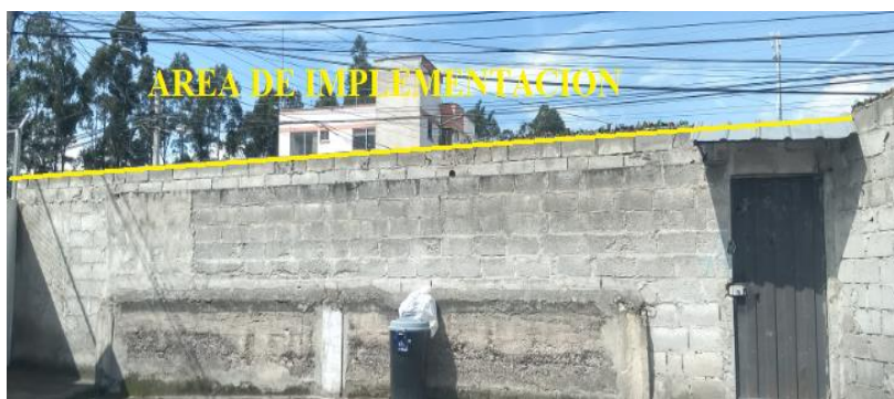
Figura 44. Implementación de Verjas de Seguridad en Acceso 12 de la Urbanización "San José del Valle".
