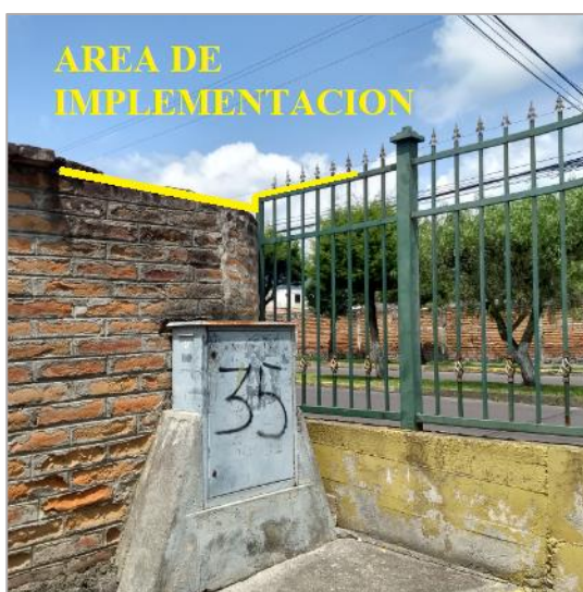
Figura 41. Implementación de Verjas de Seguridad en Acceso 8 de la Urbanización "San José del Valle".
