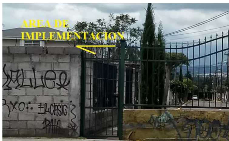
Figura 42. Implementación de Verjas de Seguridad en Acceso 10 de la Urbanización "San José del Valle".
