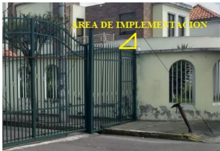
Figura 39. Implementación de Verjas de Seguridad en Acceso 2 de la Urbanización "San José del Valle".
