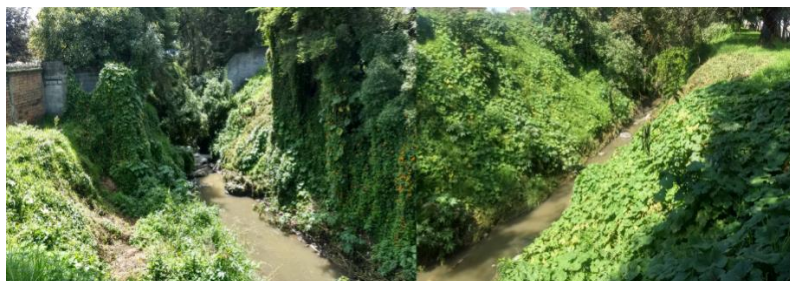
Figura 9. Fotografías Tomadas de la Quebrada-Zona Este.
