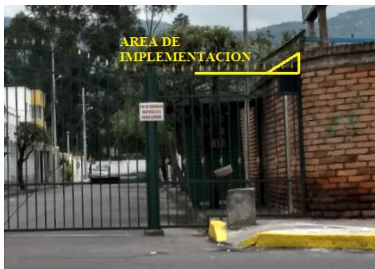
Figura 38. Implementación de Verjas de Seguridad en Acceso 1 de la Urbanización "San José del Valle".
