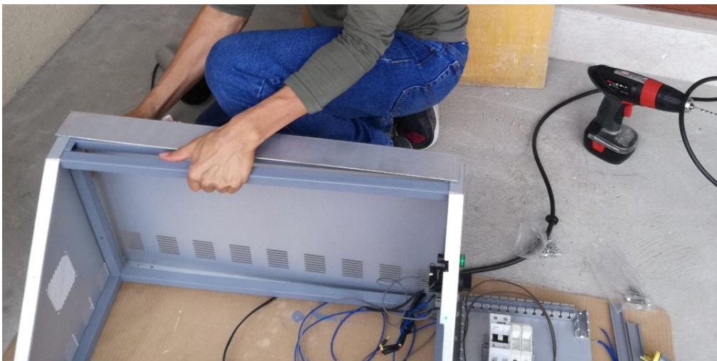
Figura 125. Ensamblaje de piezas metálicas sobre la estructura
