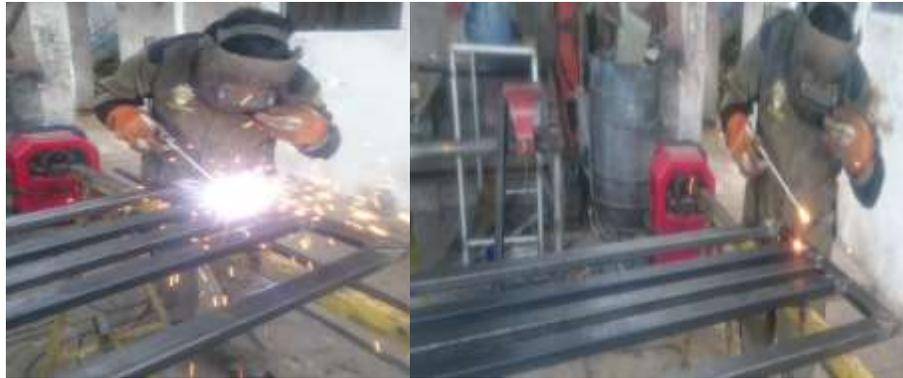
**Figura 108 Corte y soldadura de la mesa base**
