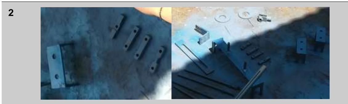
Se ensamblan los brazos salientes de sujeción al brazo de soporte general para pulirlo y pintarlo completamente.
