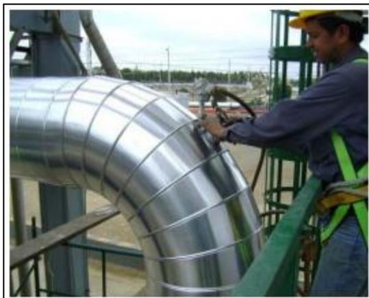
**Figura 16.** Instalación de una tubería para aislar térmicamente el calor.
