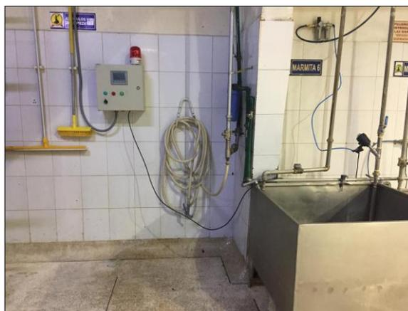
B) Montaje del sensor a la marmita de cocción
