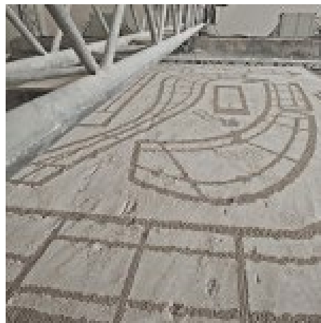
Figura 44. Impresión con la D-Shape
