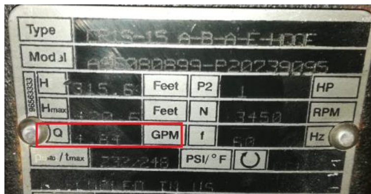
Figura 58. Características técnicas de la bomba de alimentación
