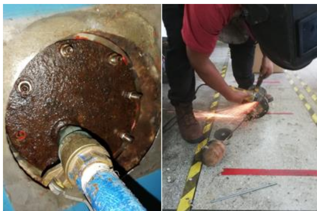
Figura 40. Tapa del tanque de condensado
