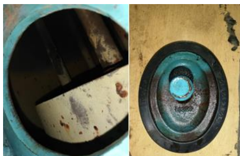
Figura 33. Parte interna del caldero del lado de agua
