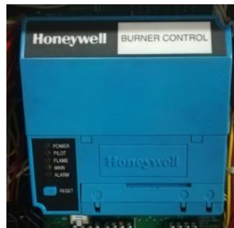
Figura 22. Controlador de fuego HONEYWELL
