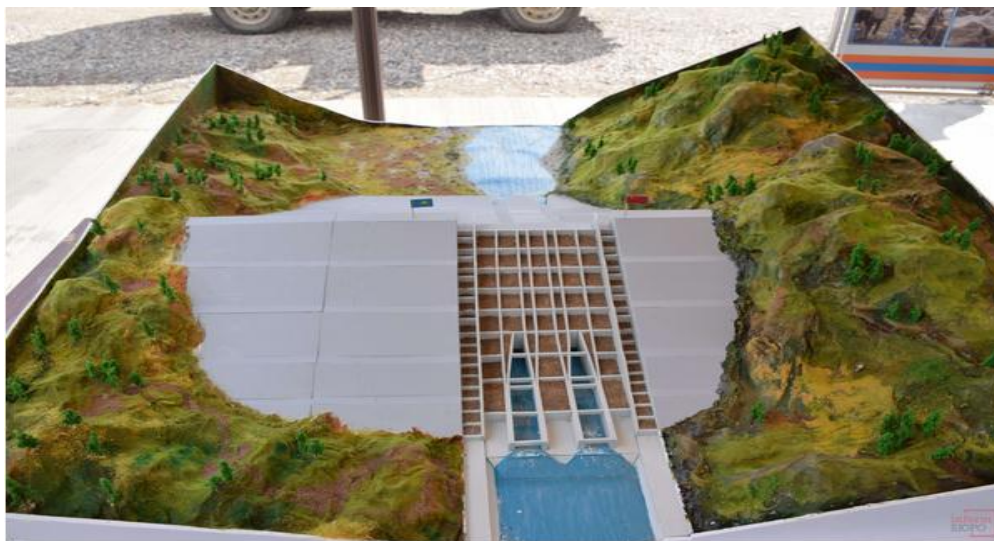
Figura 7. Presa mixta a gravedad en la región de Almaty, en el río Khorgos.
