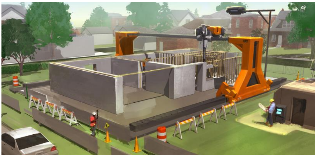
Figura 2. Impresora 3D para la construcción - Contour Crafting Fuente: (Contour Crafting Corporation, 2017)
