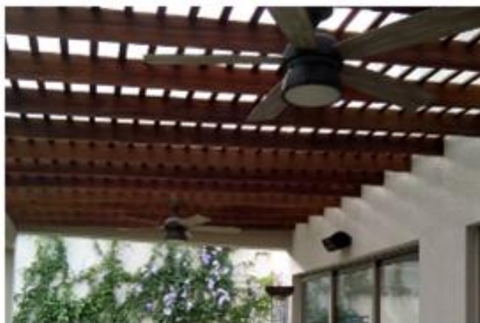
Figura 6. Pérgola hecha de madera.
