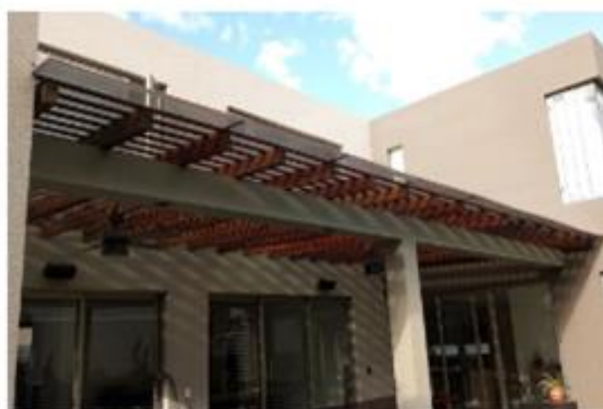
Figura 5. Pérgola con vigas de madera.
