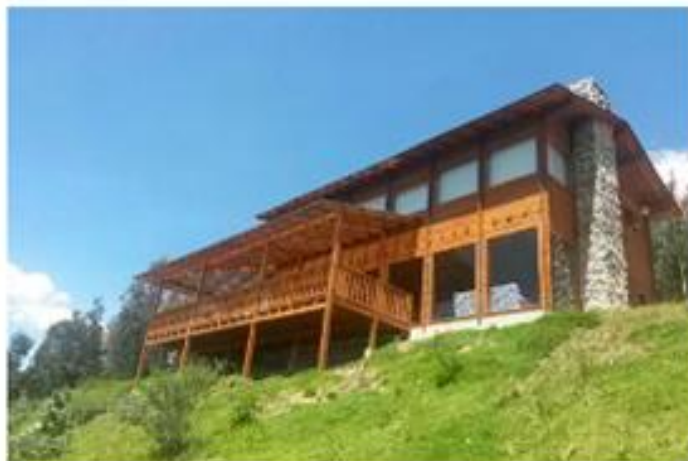
Figura 2. Casa de madera con pérgola.
