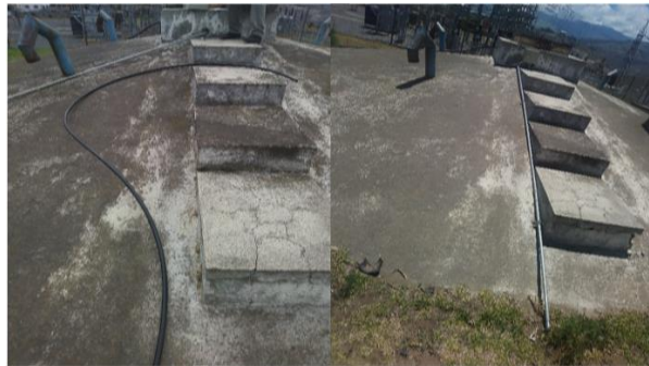
Instalación de tubería industrial
