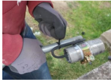
Instalación del sensor ultrasónico TSPC-15S-485
