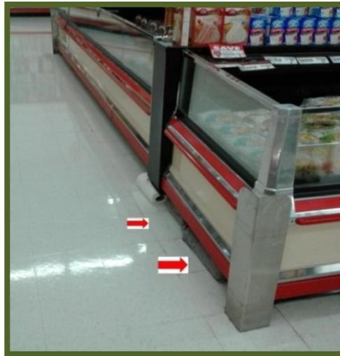
**Figura 20** Contención de derrames con almohadillas
