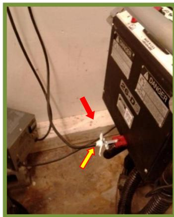
*Figura 26* Cable empalmado con plástico
