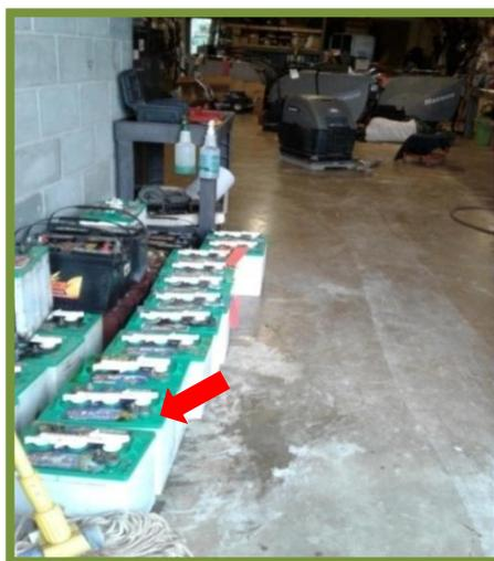
**Figura 15** Almacenamiento inadecuado de baterías
