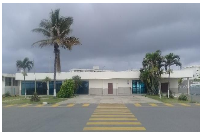
Figura 14. Terminal Aérea, vista frontal
