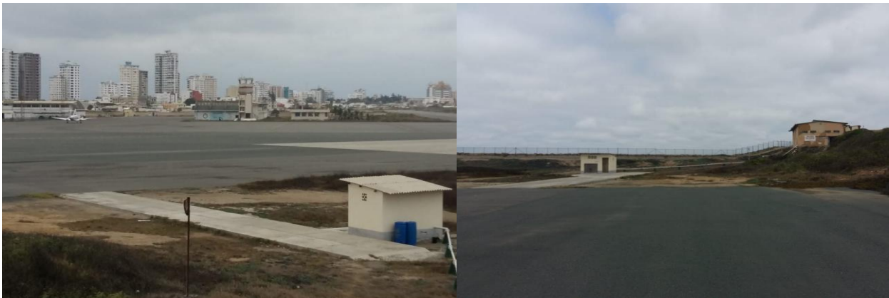
Figura 27. Vista Frontal Plataforma Militar
