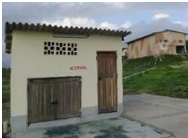
Figura 16. Surtidor Tanque de Combustible
