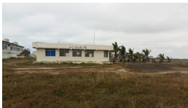
Figura 24. Estación de Bomberos (Vista Lateral)
