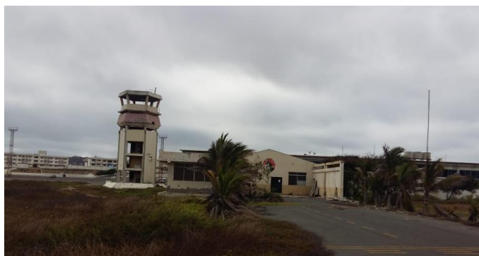
Figura 23. Estación de Bomberos (Vista Frontal)
