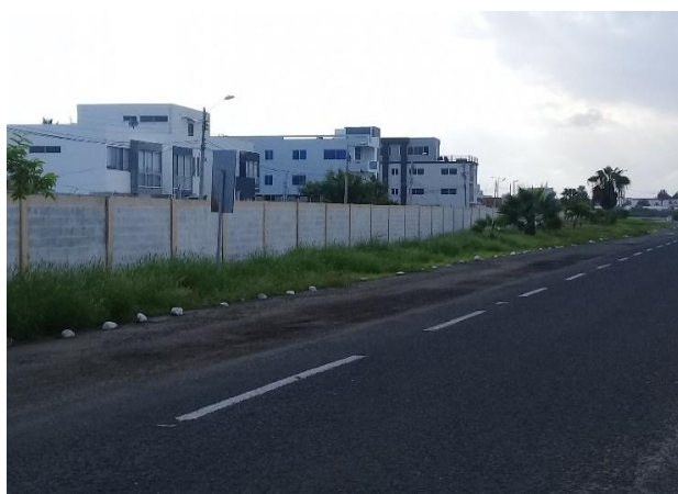
Figura 45. Cerramiento Hospital Básico
