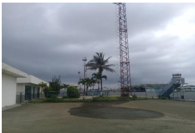
Figura 15. Terminal Aérea, vista lateral
