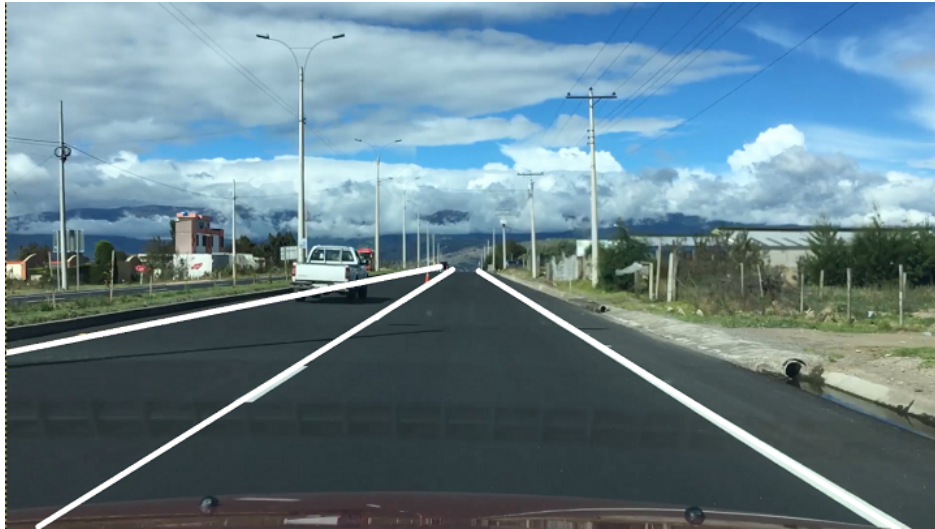
Figura 16. Subrayado de las líneas de carretera
