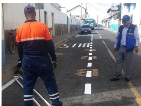
Figura 20. Trabajos viales de Urcuquí
