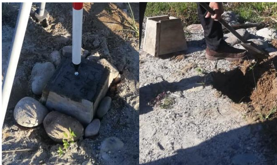
Figura 6. Construcción de hitos para puntos GPS
