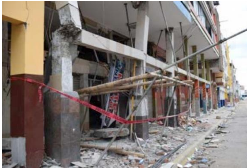
Figura 75. Apuntalamiento improvisado con acero y bambú Fuente: (Lanning et al., 2016)
