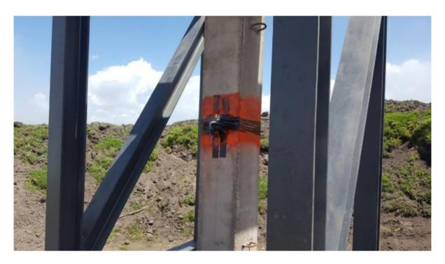
Figura 39. Colocación de carga explosiva
