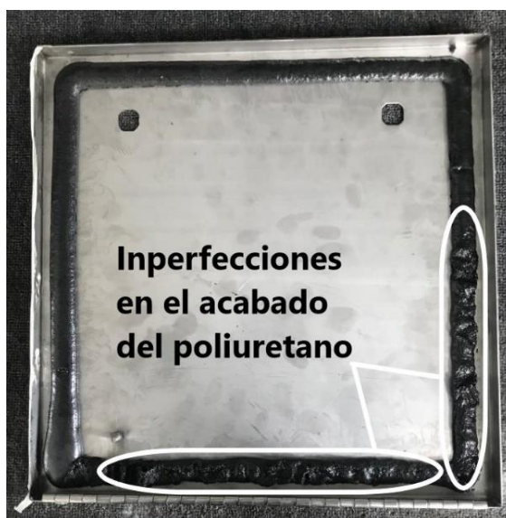
Figura 55. Imperfecciones en el acabado del poliuretano
