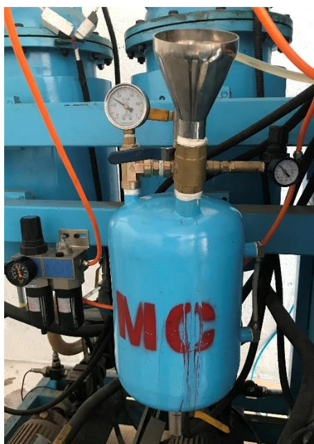
Figura 13. Tanque de cloruro de metileno
