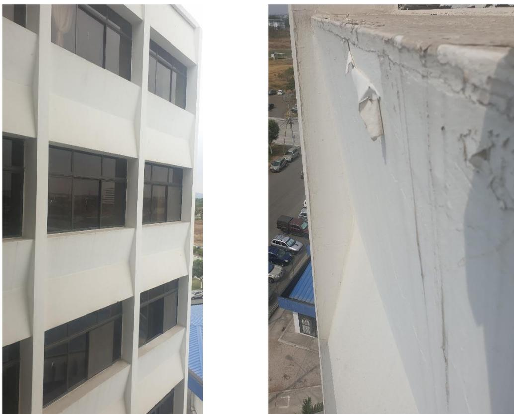
**Figura 54** Antepechos de hormigón armado en el sentido longitudinal del Hospital Naval.
