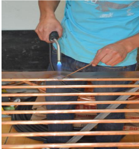
Figura 41. Soldadura de placa de cobre
