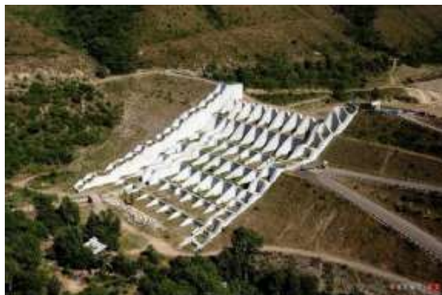
Figura 31 Presa mixta de hormigón y tierra
