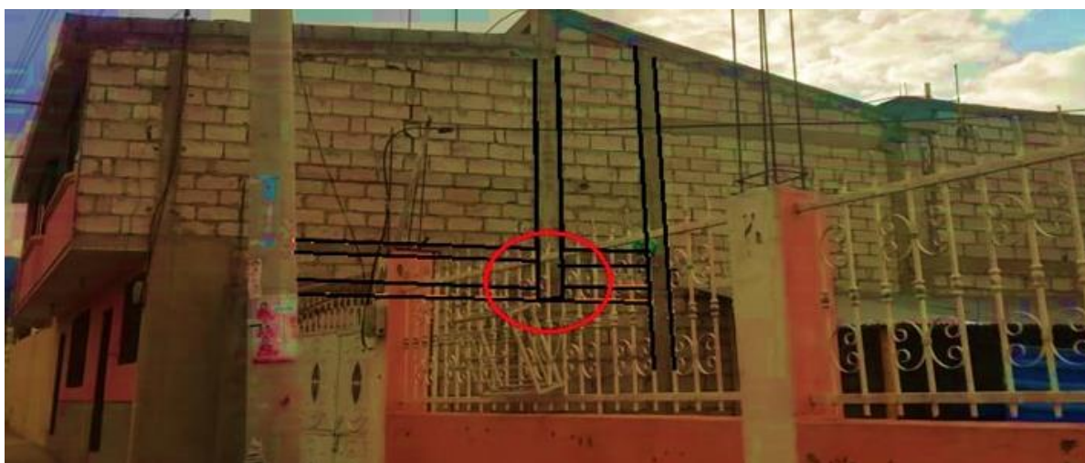
Figura 3. Columna estructural del primer nivel que nace de una viga principal
