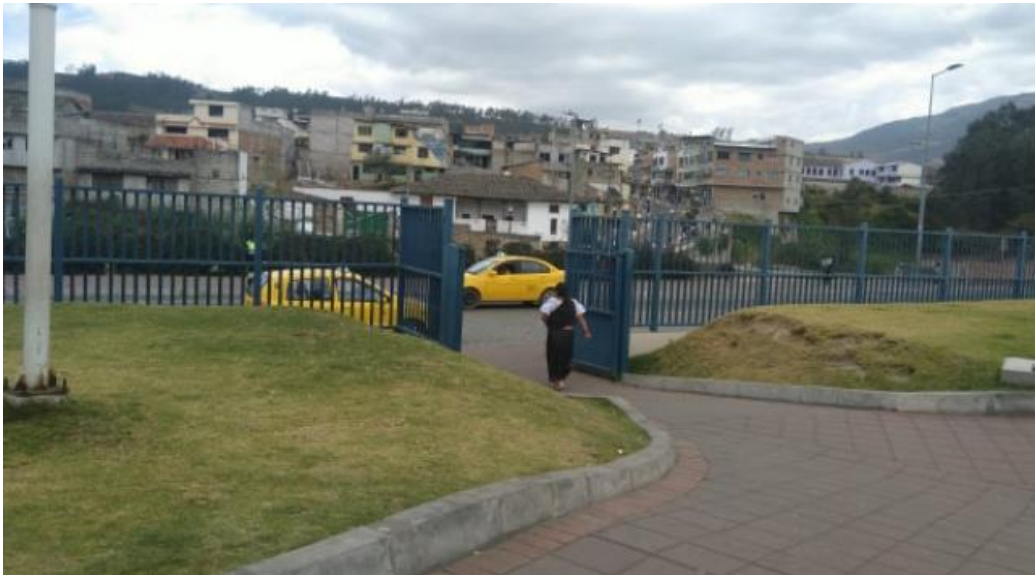
Figura 29. Debilidades de Seguridad del Acceso 23 del “Nuevo Mercado 24 de Mayo”
