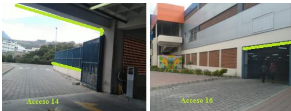
Figura 34. Falencias en seguridad del Acceso 14 y 16
