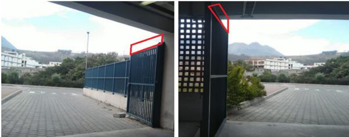
Figura 75. Implementación de verja de seguridad acceso 16
