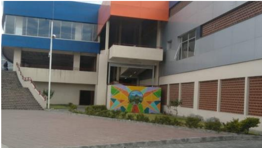
Figura 25. Debilidades de Seguridad del Acceso 2 y 3 del Nuevo Mercado 24 de Mayo
