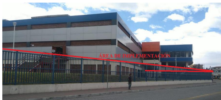
Figura 81 Implementación de bayetas de seguridad con alambre de púas en l barrera perimetral de la Av., Luis F. Cisneros
