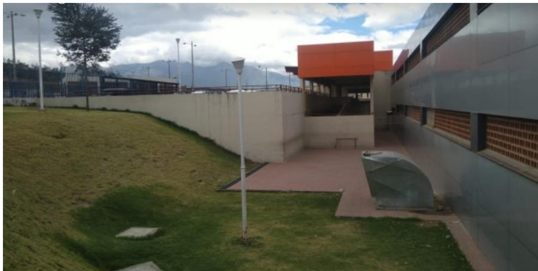
Figura 32. Falencias de seguridad de acceso 20
