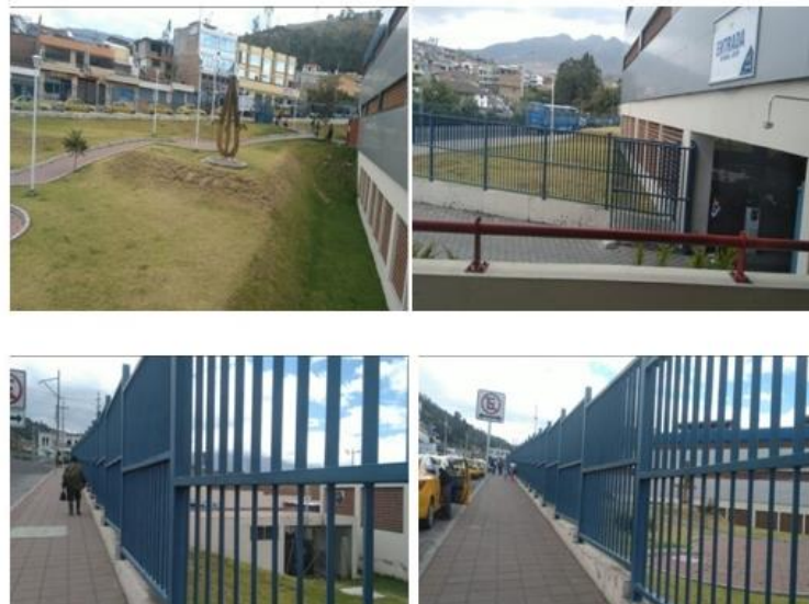
Figura 30. Debilidades de Seguridad en la Barrera Perimetral- Zona Este-Sur
