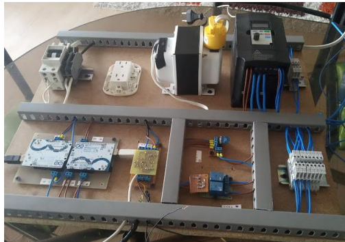
Figura 23. Cableado y montaje de elementos electrónicos
