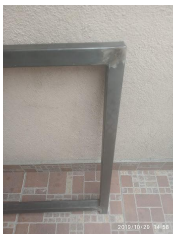
Figura 26. Soldadura marcos de la estructura
