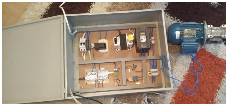
Figura 25. Montaje gabinete metálico
