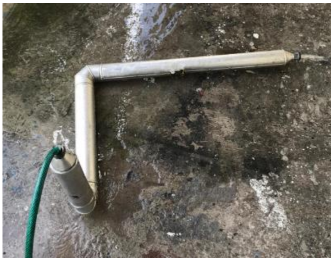
Figura 71 Limpieza Línea Retorno de Condensado
