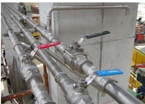
**Figura 2.2 Conducción de aire con acero inoxidable**
