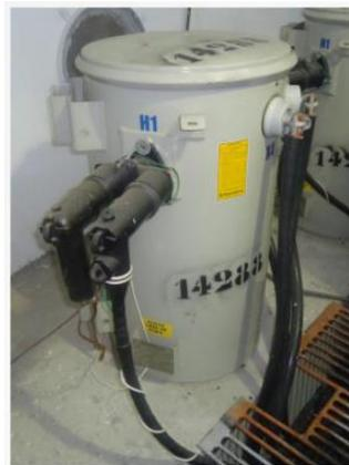
**Figura 8.** Transformador convencional monofásico con frente muerto.
