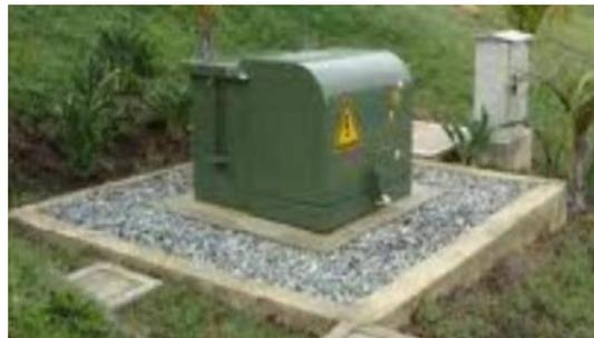
**Figura 7.** Transformadores trifásico tipo pedestal
