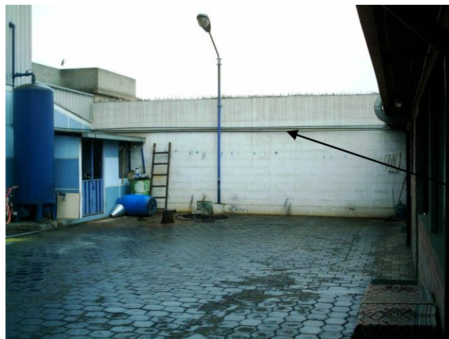
Foto E8.- Equipo de suministro de gas (línea de gas)
