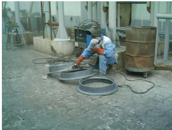
Foto Z44.- Reparación de las piezas con defectos
