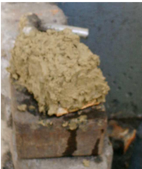
Foto Z11.- Mezcla refractaria para reparación del cubilote
