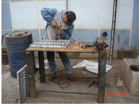
Foto Z46.- Colocación de accesorios
