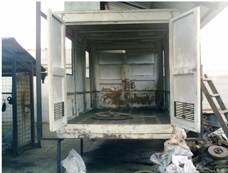
Foto F15.- Cámara de sandblasting.
