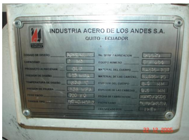
Foto E4.- Equipo de suministro de gas (placa de identificación-bomba)
