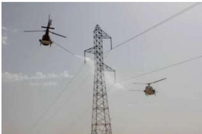
**Figura 18.** Limpieza de aisladores mediante chorros de agua a presión.
