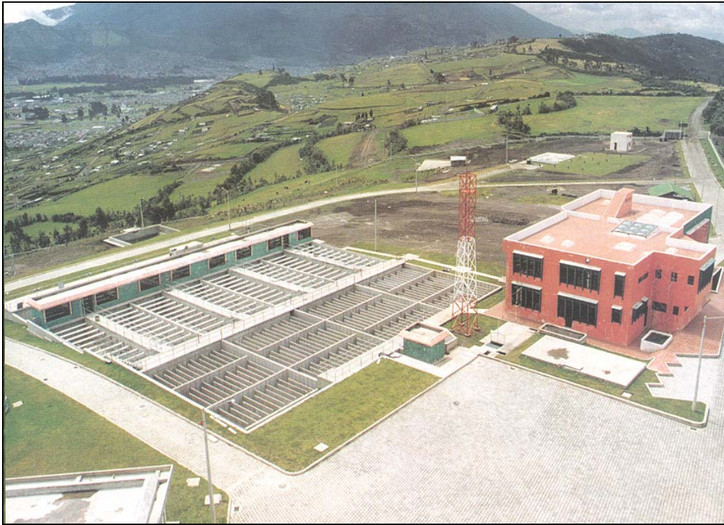
Figura. 1.12. Planta de Tratamiento El Troje (PTT)
