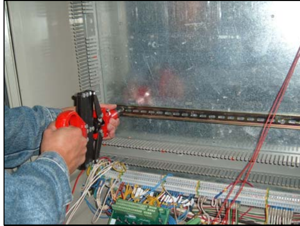
Figura. 5.4 Colocación de riel DIN
