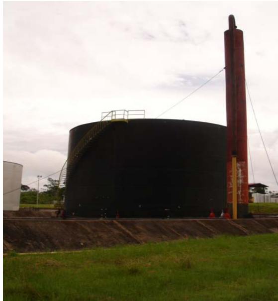
Figura 3.7: Tanque de Lavado y Bota Desgasificadora
