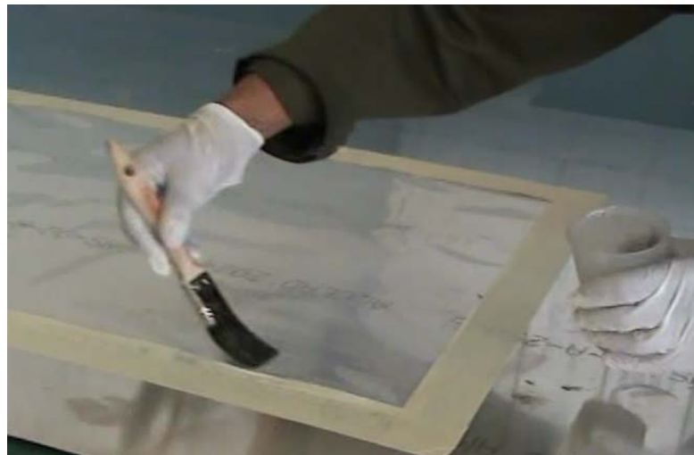
Figura 5.17 Capa de resina previa a la tela de fibra de carbono
