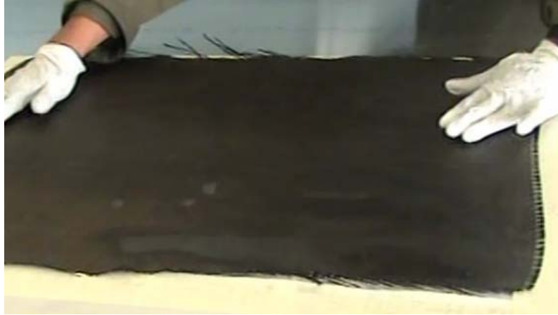
Figura 5.18 Puesta de la tela de fibra de carbono
