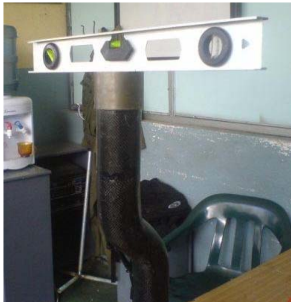
Figura 5.25 Verificación de la nivelación del acople superior
