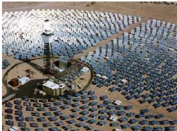
Fotografía 2.2.b Calentamiento de agua a nivel industrial 9
