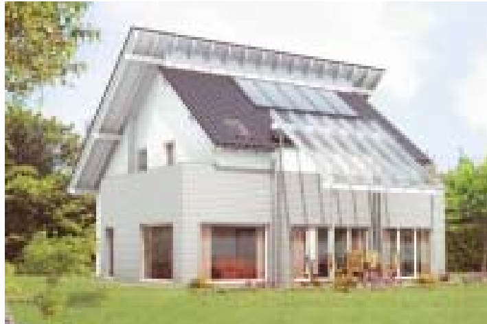
Fotografía 2.1 Colectores solares sobre el tejado inclinado de una vivienda
