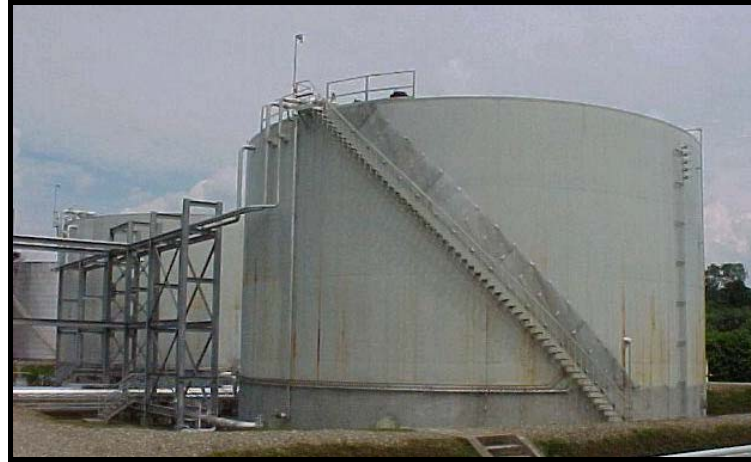
Fig. 3.17 Fotografía Tanques almacenamiento de Agua
