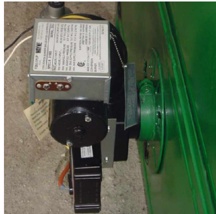
Figura 6.7 Quemador a gas electrónico.
