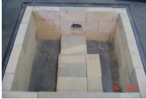
Figura 5.3 Cámara de combustión con ladrillo refractario.
