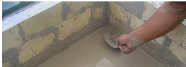
Figura 6.1 Pegada de ladrillos refractarios.
