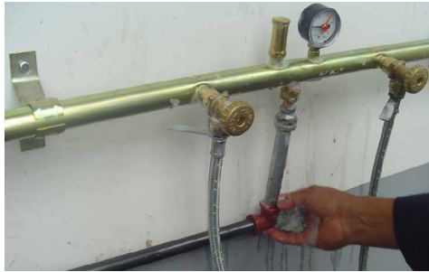
Figura 6.6 Manómetro de 25 bar .
