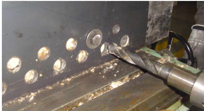
Figura 5.5 Perforaciones de 1" utilizando la mandrinadora.
