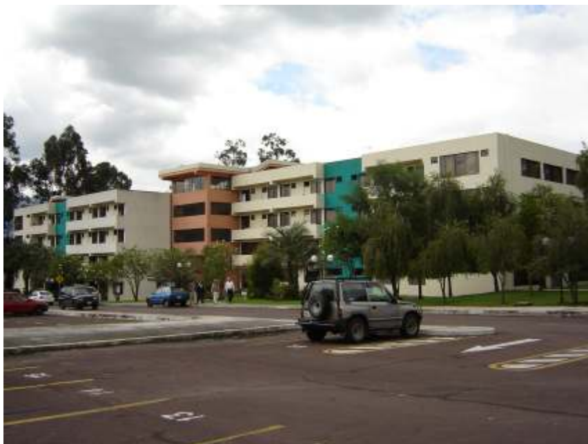
Fotografía 4.4 Parte posterior de la Residencia Politécnica
