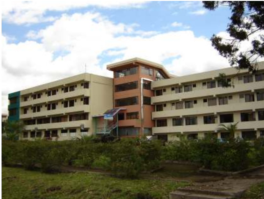
Fotografía 4.3 Parte posterior de la Residencia Politécnica
