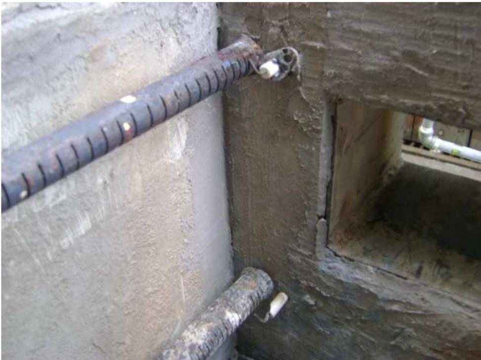
**Figura 6.3** Ubicación de las bujías para el encendido de los quemadores
