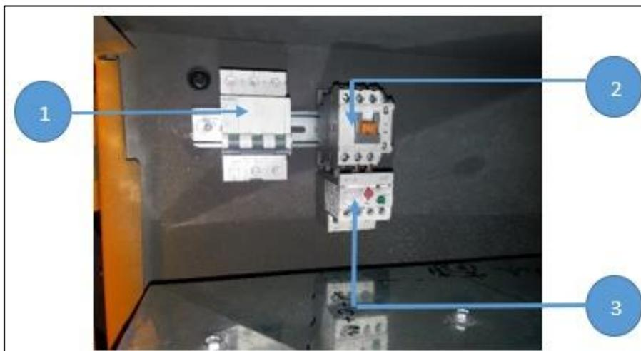
Nota. En la Figura se muestra (1) Interruptor termo magnético, (2) Contactor (3) Relé térmico.
