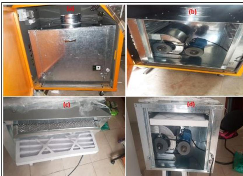
*Nota.* Se muestra en la imagen (a) sitio donde se sitúa la caja manejadora, (b) motor y ventilador centrífugo de la marca TECNIFAN, (c) pre filtro de aluminio y de cartón MERV 13 y finalmente en (d) ubicación de filtros en el sistema.
