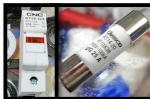
*Nota:* En el gráfico se puede observar el fusible y porta fusible, usado para la protección de sobre cargas o cortocircuitos.
