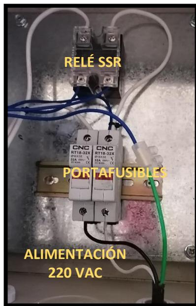
*Nota:* En el gráfico se puede observar la conexión eléctrica partiendo de la fuente de alimentación de 220 VAC hacia los fusibles y finalmente relé SSR
