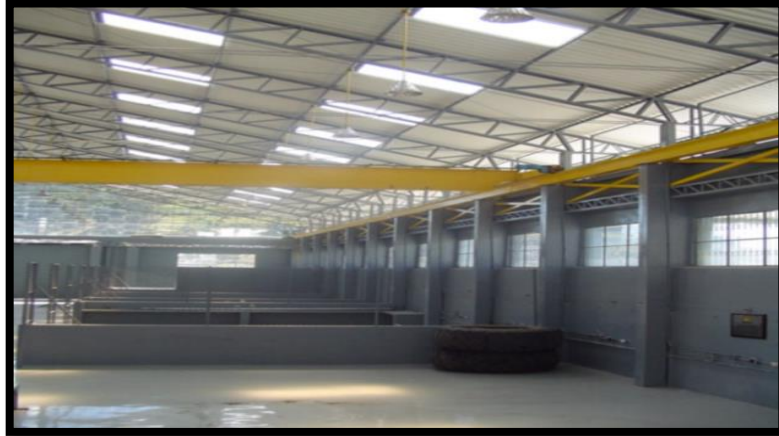
Figura. 5.16 Área De Motores Y Mecánica De Patio FUENTE: UMAT C.E.E.
