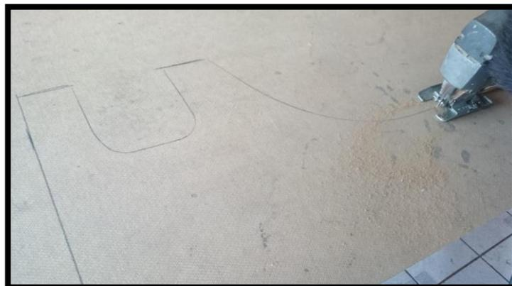
Figura 61 Corte del material
