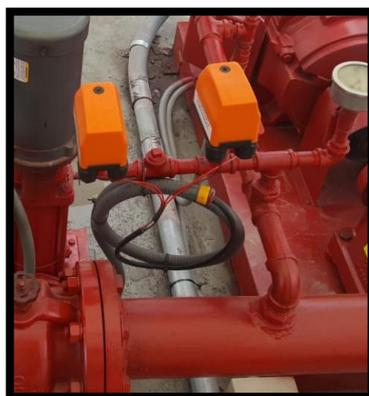
**Figura 38 Colocación de presostatos**
