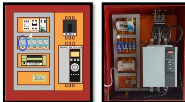
**Figura 62 Relé de voltaje**
