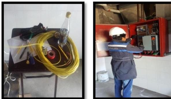
**Figura 81 Conexiones con el alambre flexible N°18 AWG**
