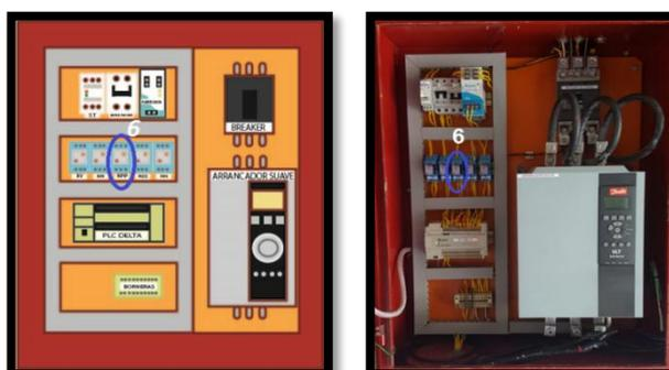
**Figura 64** Relé del presostato de la bomba principal
