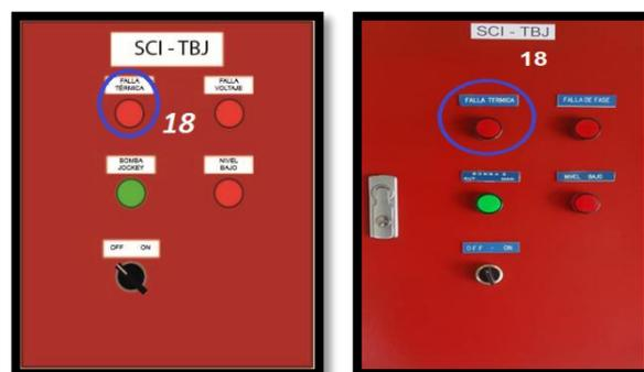
**Figura 76 Indicador de falla térmica**
