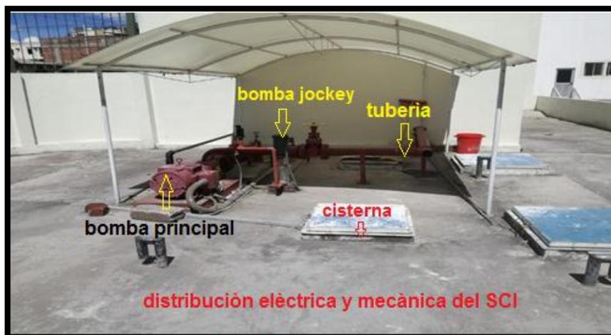
**Figura 29 Inspección visual del SCI**
