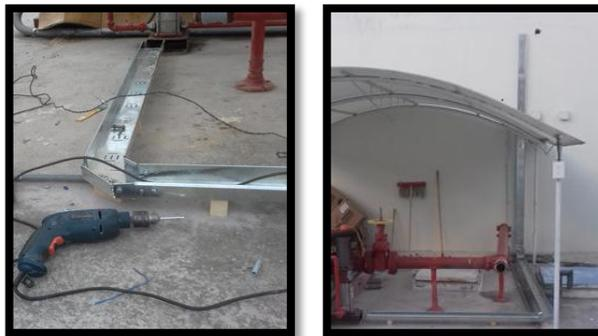
**Figura 84 Colocación de la bandeja portacables en el área exterior**
