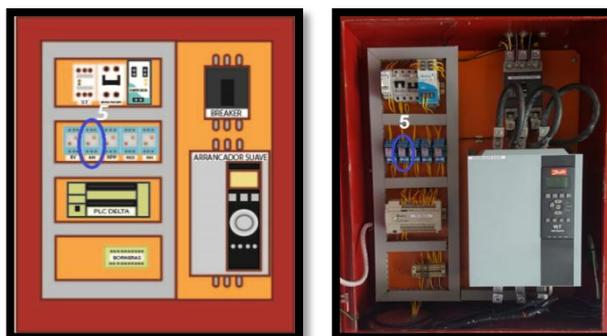
**Figura 63** Relé del presostato de la bomba jockey
