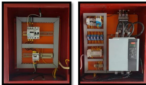
**Figura 83** Nuevas conexiones realizadas en los tableros de control SCI
