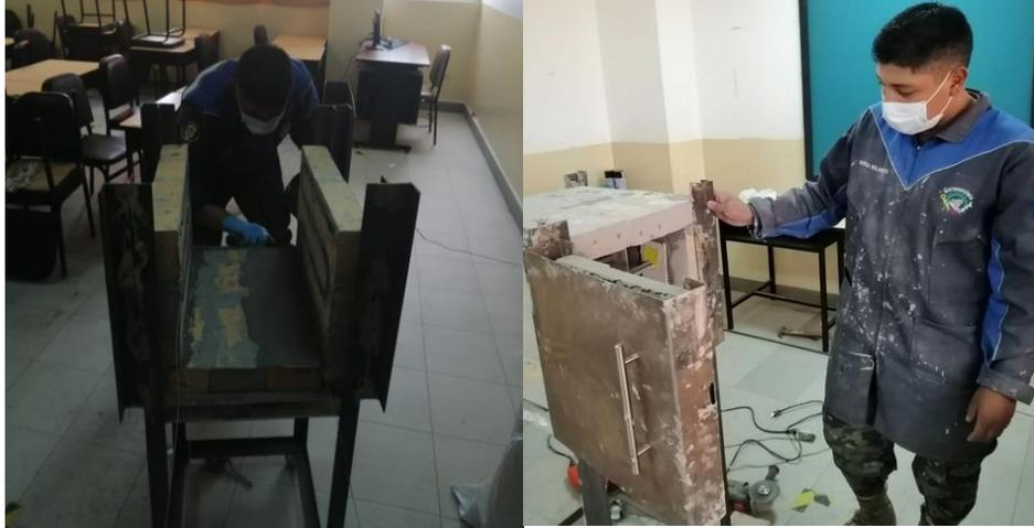
*Nota.* La imagen muestra como se arma la cámara interna del horno y se fija con mortero refractario.
