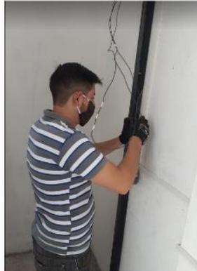
De la misma forma se realiza el cableado de la planta alta sin embargo para colocar el final de carrera superior fue necesario realizar una platina tipo L y soldarla a la guía (ver Figura 56) colocando la cabina a nivel del piso del acceso logrando así que no exista ninguna grada que pueda dificultar la movilidad del ocupante.
