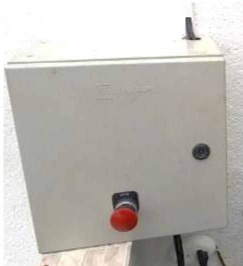
Antes de la adquisición del gabinete de control es prudente realizar un bosquejo con todos los elementos que integraran el circuito de automatización para así determinar el tamaño de la caja. Hay que recordar también que en el interior del tablero los cables deben estar colocados dentro de canaletas ranuradas de manera ordenada e identificados de acuerdo a la normativa vigente
