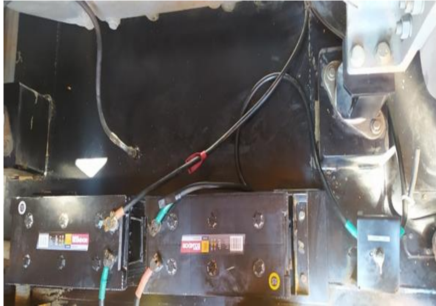
Conexión de baterías
