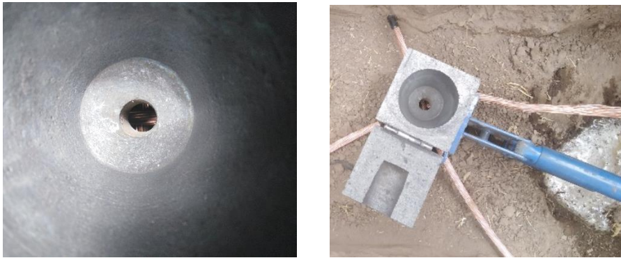
Figura 111. Conductor ubicado en el molde de grafito
