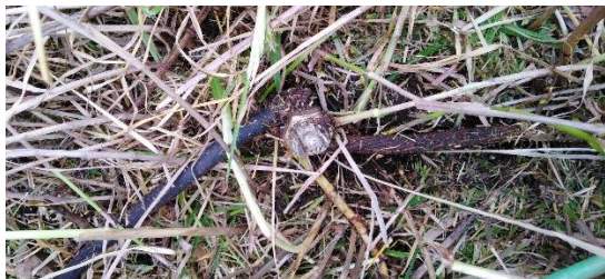
Figura 76. Unión de mallas MTD y MP3 mediante conectores
