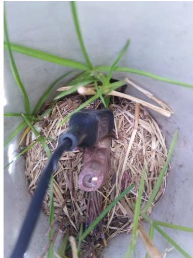
Figura 66. Conexión al electrodo de tierra
