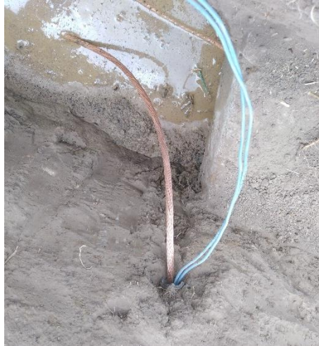
Figura 116. Conductor tapado con GEM
