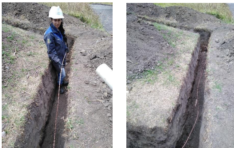
Figura 109. Tendido de cable
