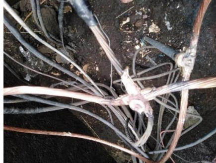
Figura 122. Uniones en pozo de revisión
