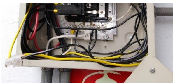
Figura 81. Tablero Secundario
