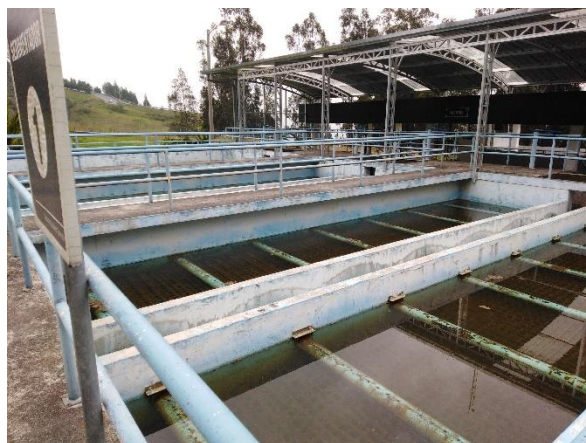
Figura 3. Sedimentadores
