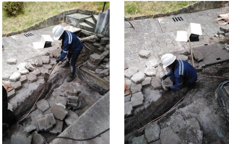
Figura 121. Conducción del conductor al pozo
