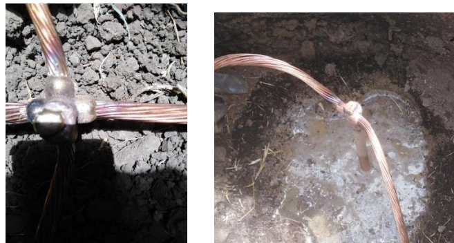
Figura 115. Correcta suelda exotérmica
