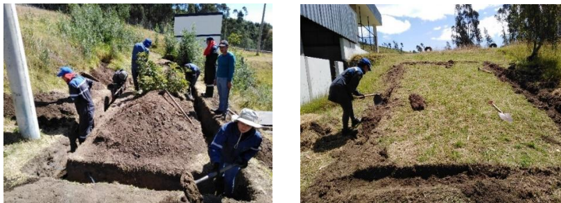
Figura 100. Formación de canales para MTCI
