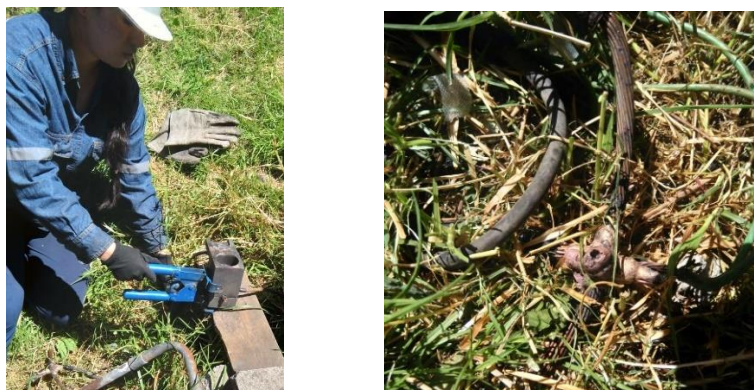
Figura 123. Colocación de bobina de choque
