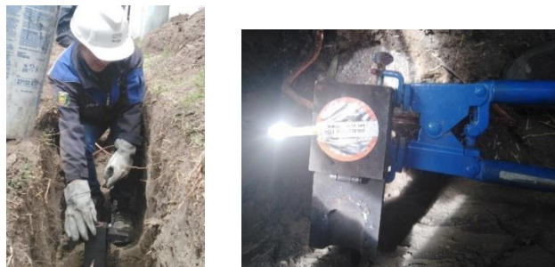
Figura 113. Preparación del recipiente metálico, Cadweld Plus 115
