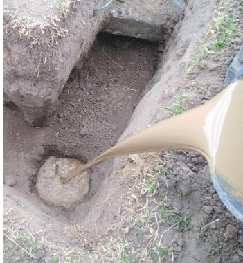
Figura 108. Relleno de hoyos con la mezcla de GEM
