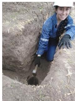
Figura 101. Colocación de la varilla de tierra en hoyo
