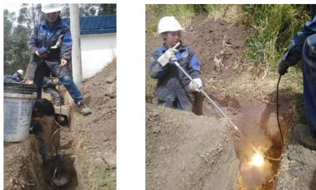
Figura 114. Suelda exotérmica
