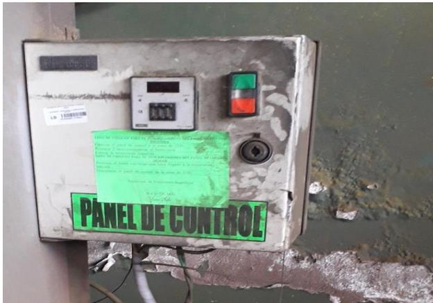
El sistema de control se encuentra en mal estado lo que ocasiona que el equipo no arranque.
