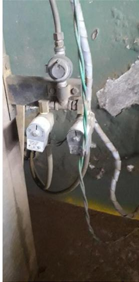
El sistema de sistema eléctrico del quemador de gas se encontraba en mal estado lo que permitía que se enclave el ventilador .
