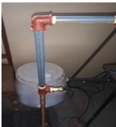
Figura 26. Colocación Codo 90°
