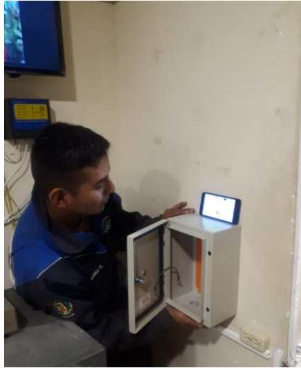
Figura 36. Instalación de caja térmica
